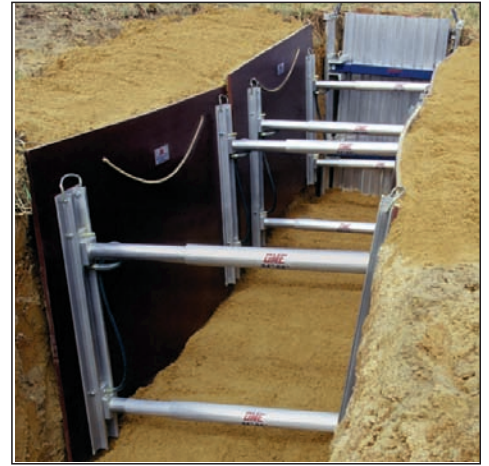
Escoramento hidráulico vertical
