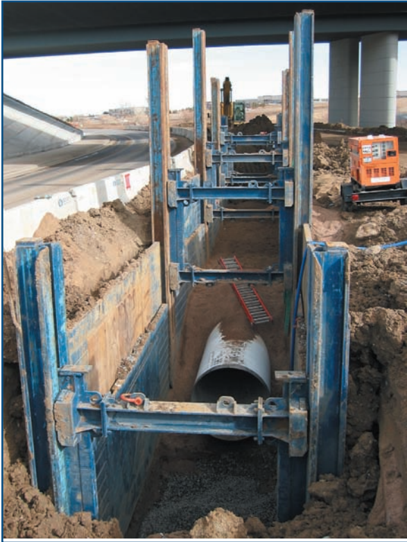
O sistema modular de trilhos deslizantes GME/E+S em uma aplicação linear.
