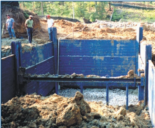
O sistema modular de trilhos deslizantes GME/E+S usado em poço.
